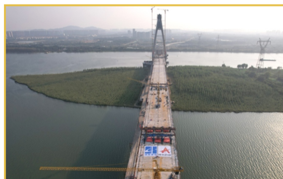
▲10月22日，香炉洲大桥项目河东主桥中跨顺利合龙，标志着主体工程全部完成。
